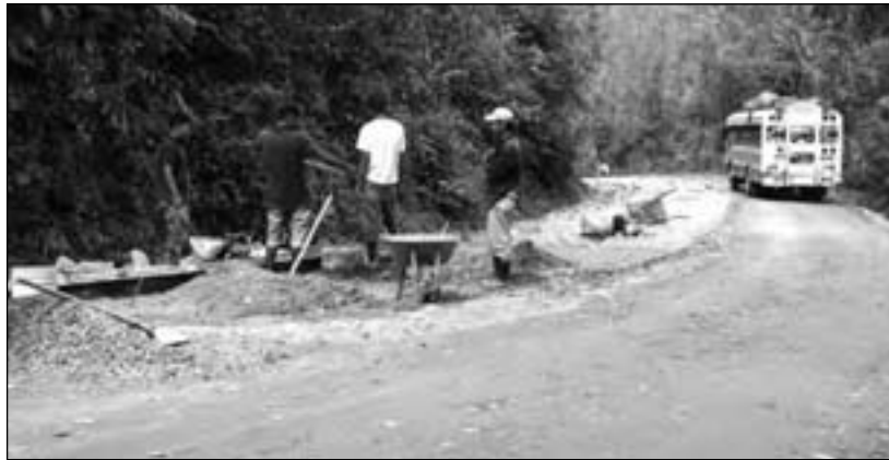
Entre las críticas hechas al proyecto está la contratación de personal no calificado.
